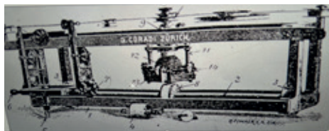
Figure 5 : Analyseur harmonique de Coradi © Lebée, Inventaire général /École polytechnique
