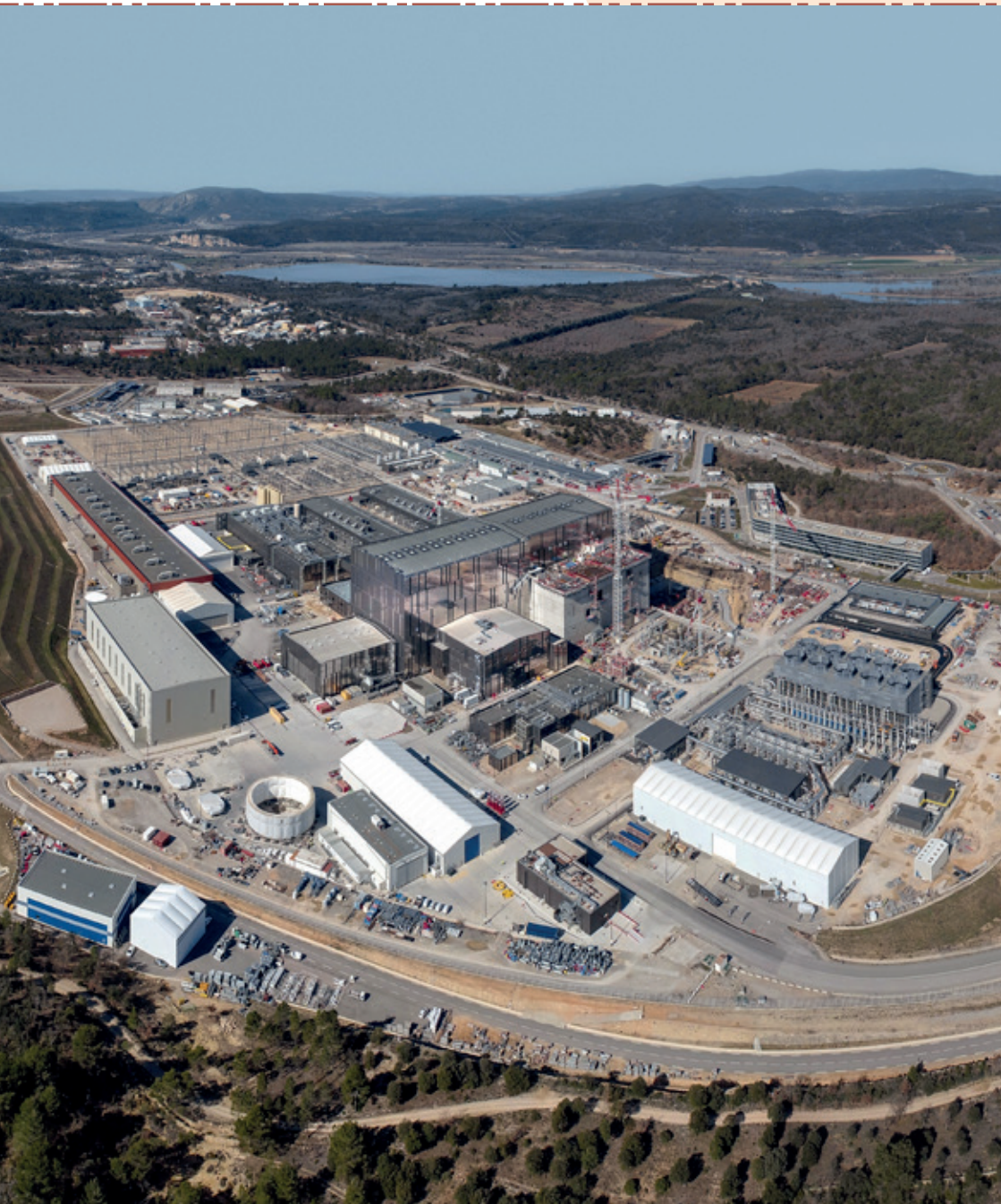
Figure 6 : Vue du chantier Iter à Cadarache en mars 2023 avec au centre les deux bâtiments adjacents de l'assemblage et du réacteur. Le site a une superficie totale de cent quatre-vingt et un hectares. (crédit : ITER Organization)
